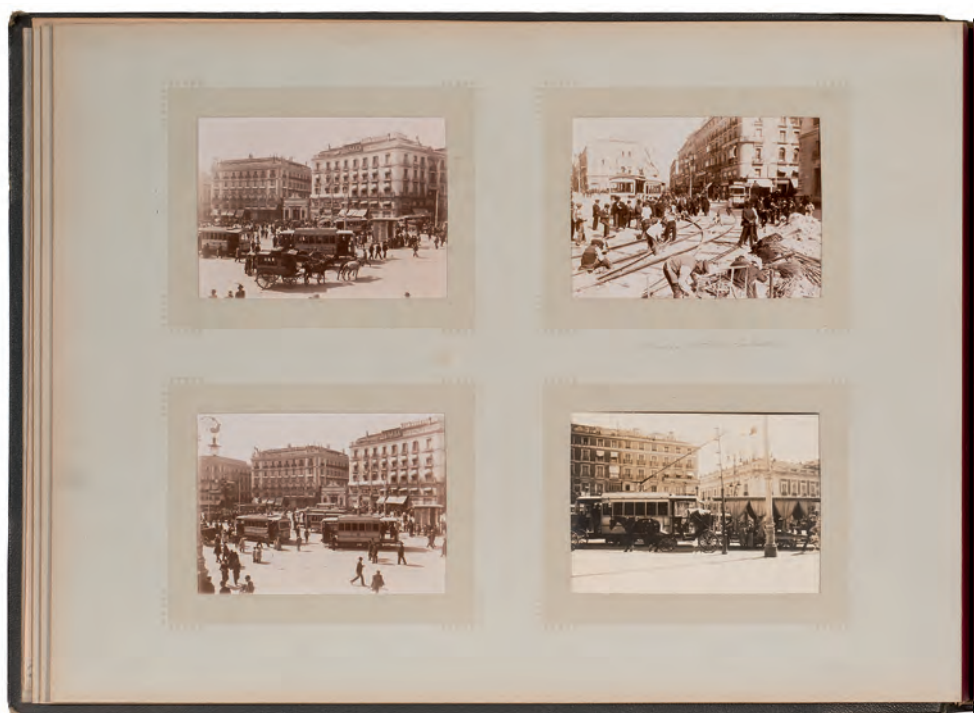
[Construcción de las líneas eléctricas del tranvía en Madrid]
