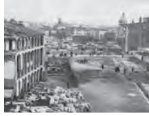
Primeros derribos de la Gran Vía 1910
