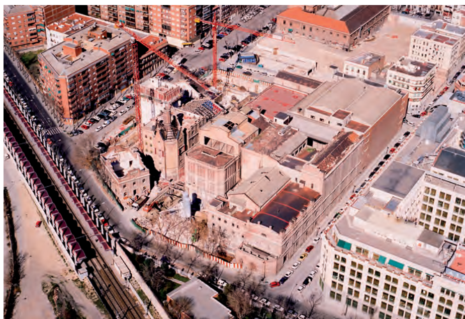
Fotografías aéreas de las distintas fases de remodelación (Dragados)
