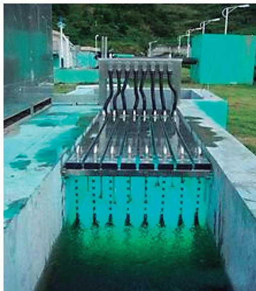
Figura 30. Instalación de un equipo de radiación UV, en una instalación de tratamiento del agua.
