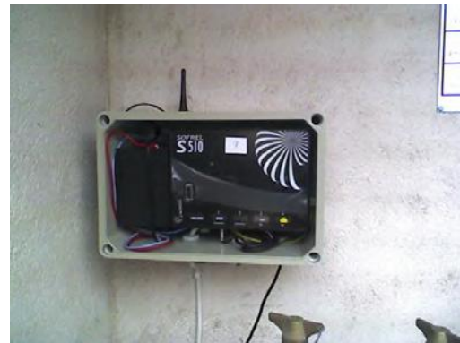
FIGURA 81. ESTACIÓN REMOTA DE CONTROL. DERECHA (DENTRO DE CAJA PROTECTORA IP 68)
