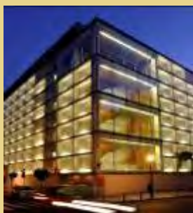
Edificio de depósitos
