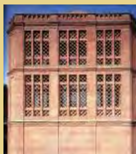
Edificio de oficinas
