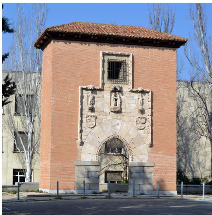
↑ Hospital de La Latina. Fachada del hospital a la calle de Toledo poco antes de su derribo y portada actual. Fue Francisco Ramírez de Madrid «el Artillero», quien estableció su fundación en 1499 por manda testamentaria, con la advocación de Nuestra Señora de la Concepción, quedando concluido hacia 1507 por su esposa Beatriz Galindo «la Latina», según trazas de maestre Hazán. Tras la demolición del edificio en 1904-1907, se trasladó su bella portada, de estilo gótico mudéjar, junto a la entrada de la Escuela Superior de Arquitectura.
