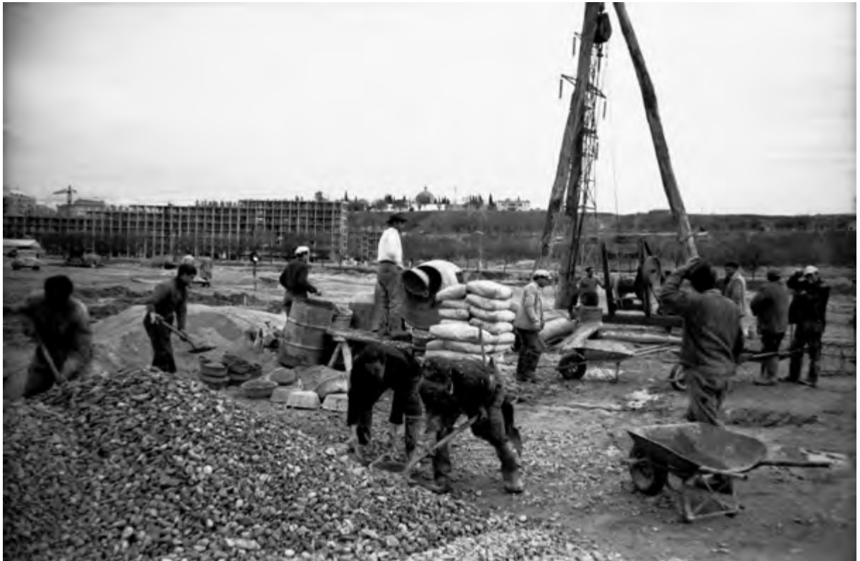
Inicio de las obras de construcción del Estadio del Manzanares en 1959, sobre el antiguo barrio de las Cambroneras. Tras él, y cruzando el río, también se construyen las viviendas del paseo del Manzanares. Al fondo, la Sacramental de Santa María, actualmente colindante con el parque de San Isidro.
