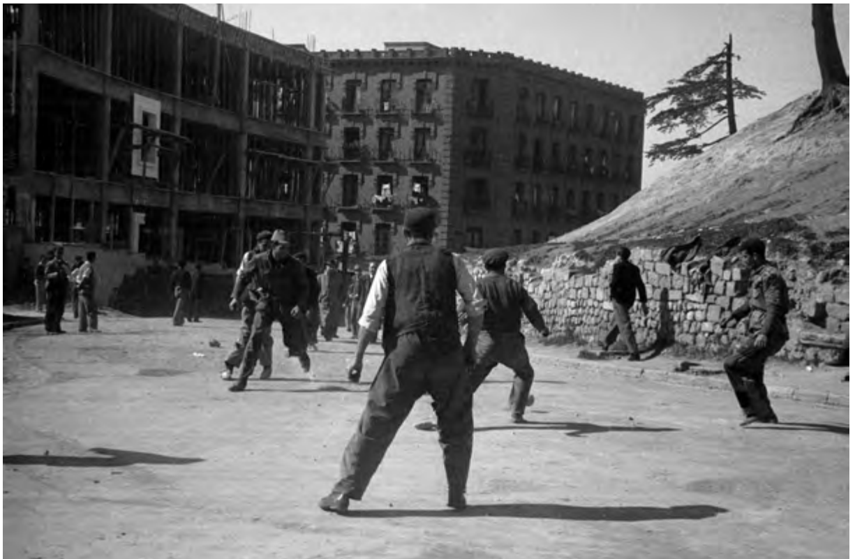
Un grupo de albañiles juega al fútbol en la calle de Irún en 1952. El edificio en construcción fue la sede de la compañía Kodak y ha sido recientemente derribado. A la derecha se ve el talud de una desolada montaña del Príncipe Pío. ARCM. Fondo Martín Santos Yubero. Signatura 009509_006
