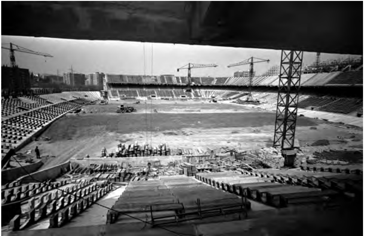
Construcción del graderío del Estadio del Manzanares, en marzo de 1966. El campo se inauguró el 2 de octubre del mismo año. ARCM. Fondo Martín Santos Yubero. Signatura 024299_001
