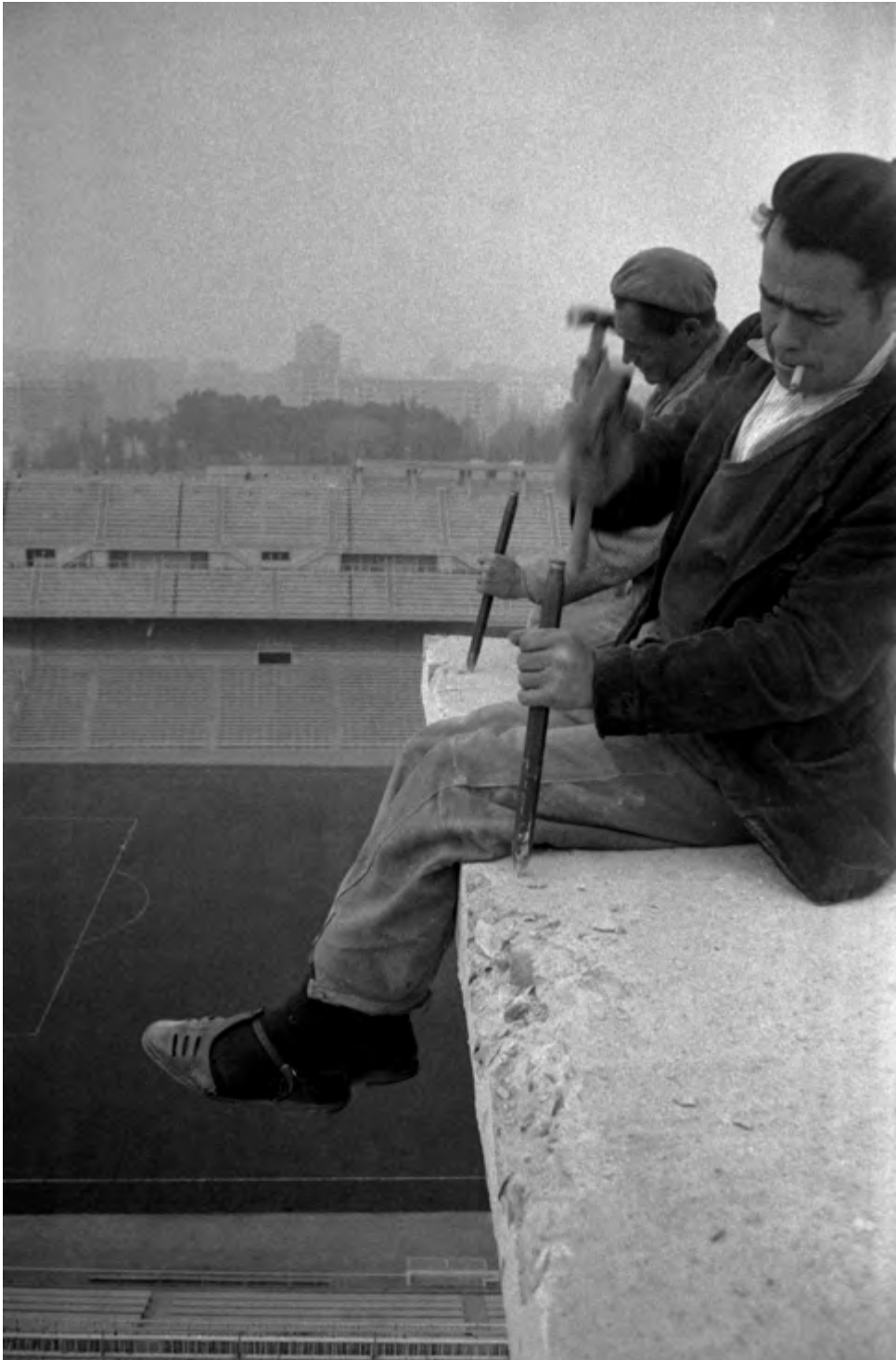
Operarios instalando la nueva iluminación nocturna del Estadio Santiago Bernabéu en febrero de 1957. ARCM. Fondo Martín Santos Yubero. Signatura 014588_004
