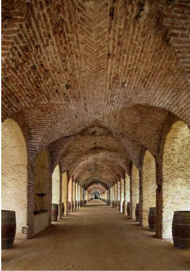
Bodega Real Cortijo de San Isidro
