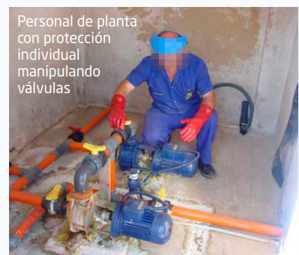
Sistema automático de dosificación con protección en bombas de dosificación
