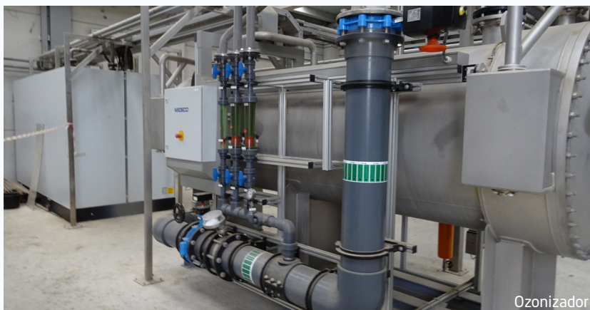
Señalización en la entrada a sala de ozono
