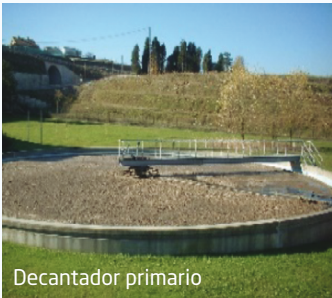
Decantador primario vacío
