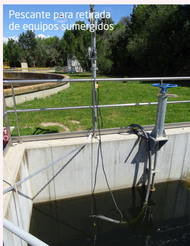
Detalle de anclaje de pescante en balsa
