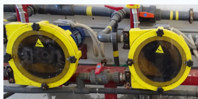
Sistema automático de dosificación con protección en bombas de dosificación
