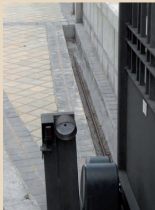
Fotocélula de espejo en puerta corredera
