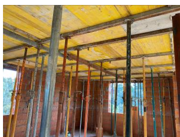
Figura 2.-Sistema de entablado colocado desde arriba
