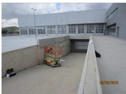
Figura 1: Vista de la posición en que quedó la PEMP en la rampa después de arrollar al trabajador accidentado
