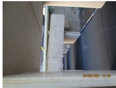
Figura 3: Hueco entre los bloques implicado
