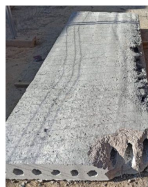
Figuras 3 y 4: Estado de la placa después del accidente
