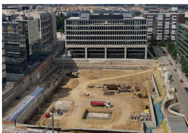
Fig. 1. Perspectiva de una obra en fase de vaciado similar a la existente donde ocurrió el accidente.
