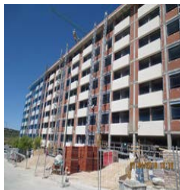
Foto 3: Edificio en construcción
