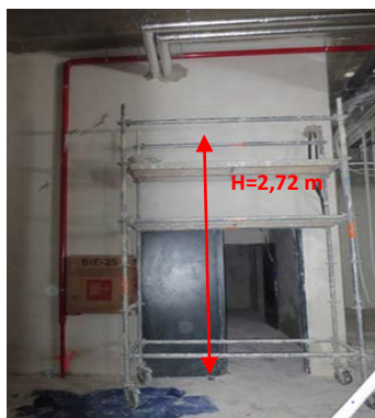
Foto 1: Andamio visto de frente
