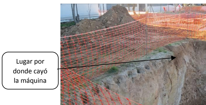
Figura 1: Hueco de la piscina y montón de tierra
