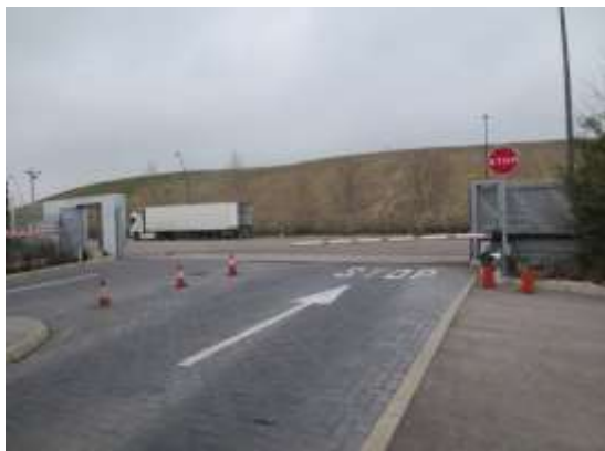
Figura 1: Vista general del portón implicado en el accidente
