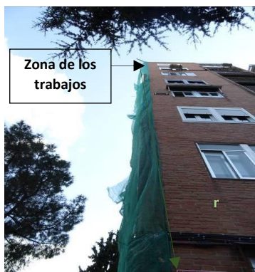
Foto 1: Edificio en rehabilitación
