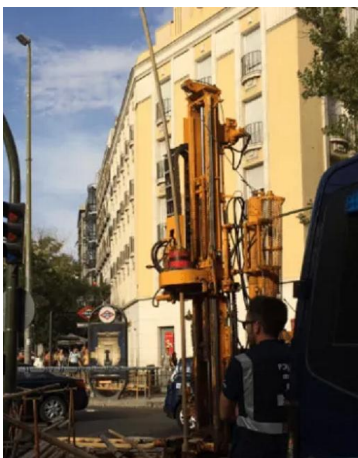
Figuras 1: Máquina de sondeo con la sarta de varillas. Se aprecia la curvatura anormal por la elevada altura de la sarta.
