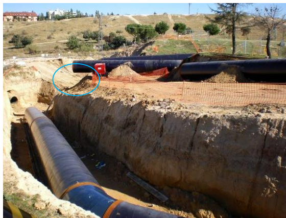
Zanja y canalización. Marcada zona de vuelco del rodillo
