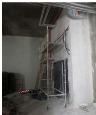
Foto 2: Vista lateral del andamio
