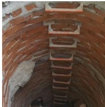
Pozo de acceso a la galería en construcción y escalera de pates del interior del pozo
