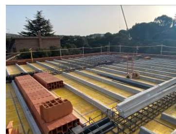
Figura 3. Vista superior del forjado en ejecución
