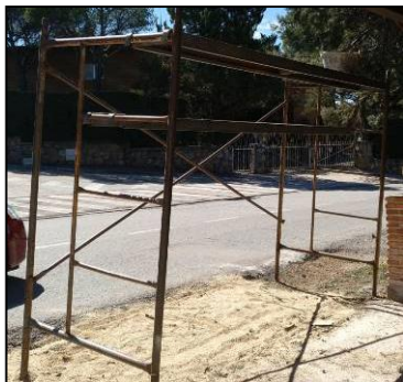
Figura 1: Configuración similar de andamio
