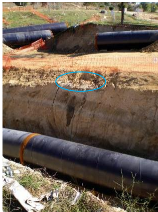
Zanja y canalización. Marcada zona de vuelco del rodillo
