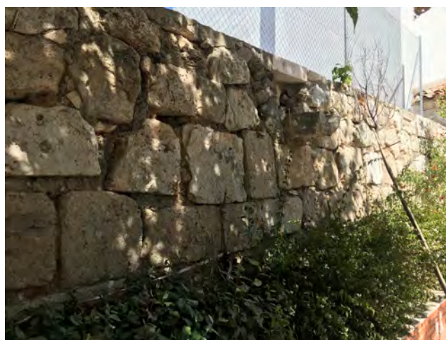
Figura 21. Detalle de las piedras y sillares reutilizados en un muro del parque de la calle de la Era.
