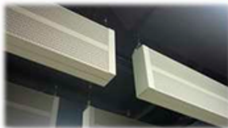
Figura 4. Paneles absorbentes en techos de un taller mecánico.
