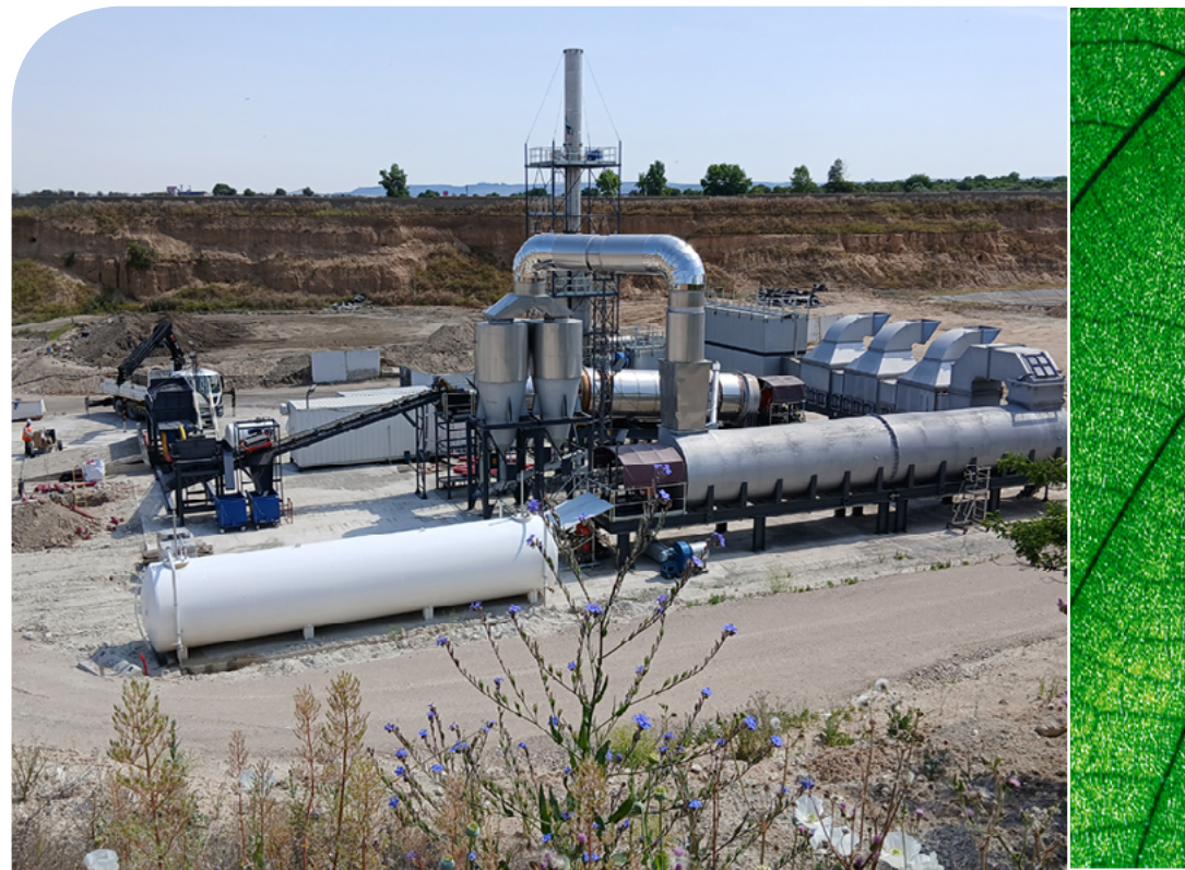
Planta de desorción térmica instalada en la laguna de los aceites.
