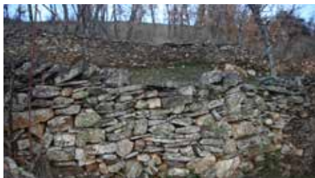
Muro de piedra seca
