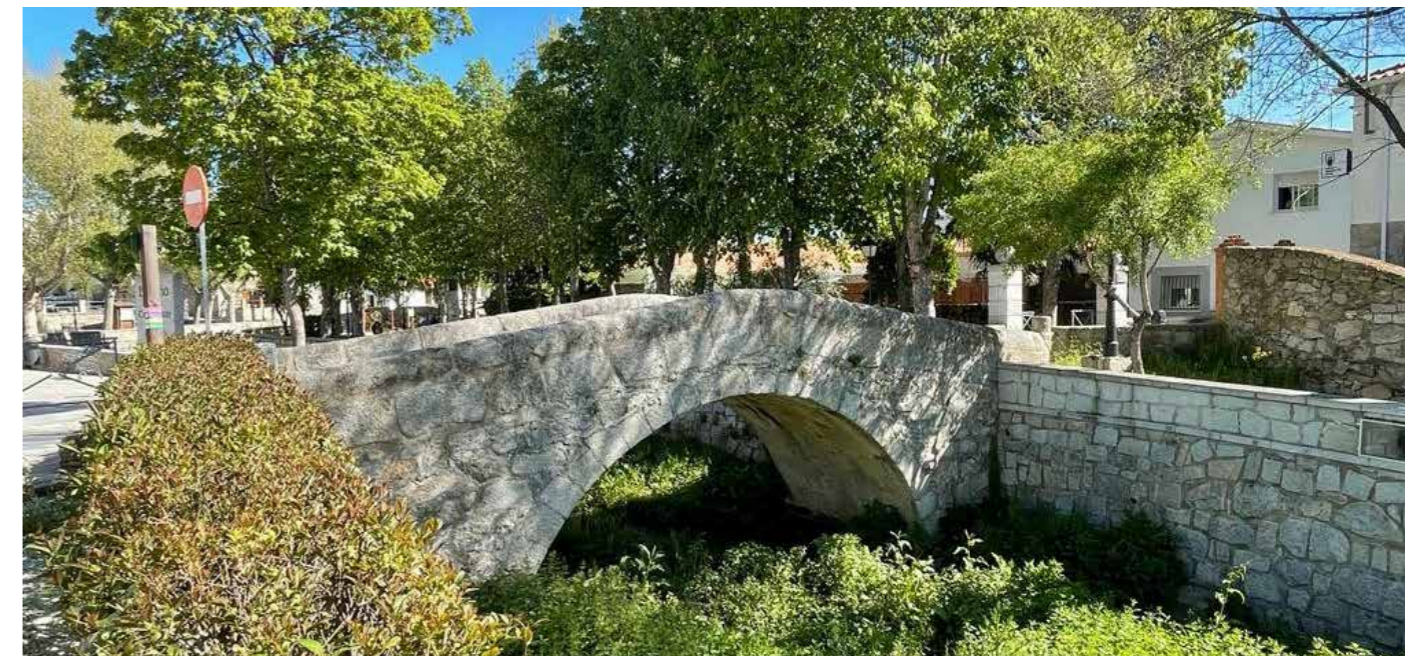
Puente de La Fragua. Colmenar del Arroyo.
