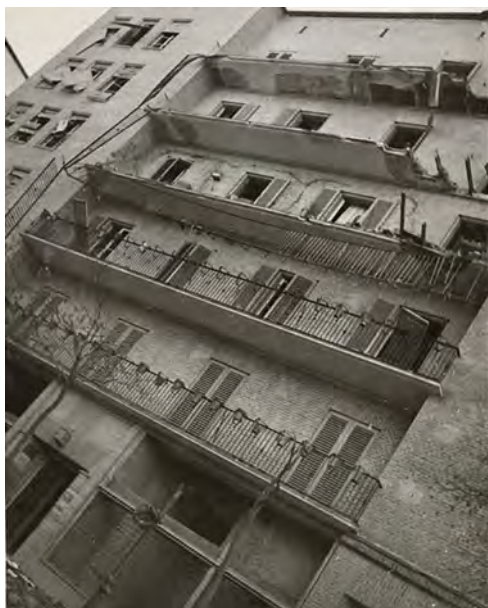
Casa de las Flores, por Meléndez Valdés, 61, bombardeada. Nótese el balcón de Neruda, en la última planta, semidesplomado.
