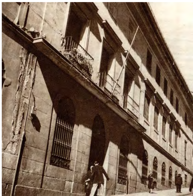
Antigua maternidad en la calle Mesón de Paredes, 66.
