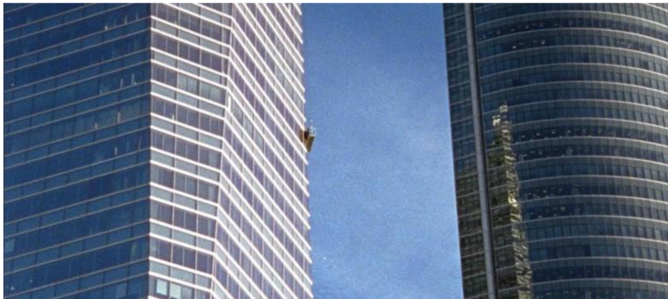
Detalle de la Torre de Cristal y la Torre PwC de CTBA (Cuatro Torres Business Area) de Madrid
